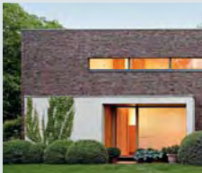
Einfamilienhaus Kevelaer, Deutschland
