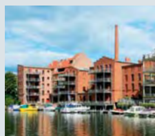
Atelierwohnungen Brandenburg, Deutschland
