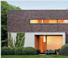
Einfamilienhaus Kevelaer, Deutschland
