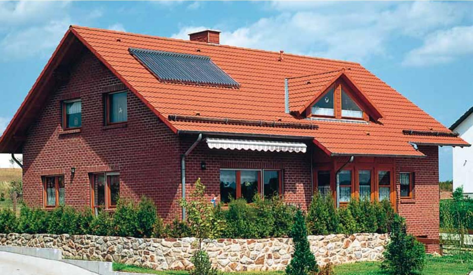
Röhrenkollektoren können lageunabhängig montiert werden.
